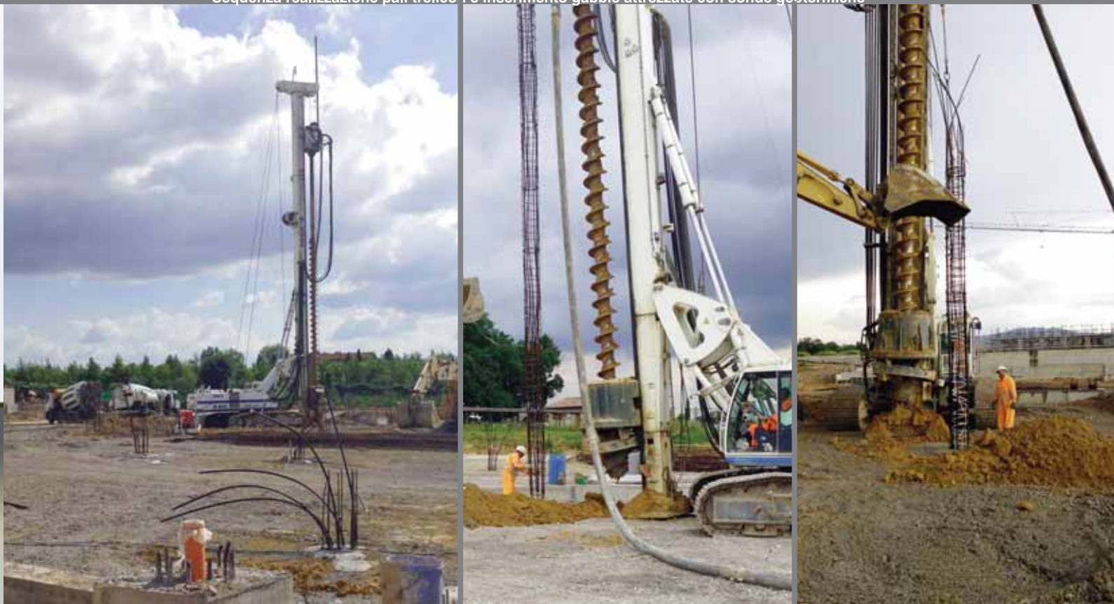
Sequenza realizzazione pali trelicon e inserimento gabbie attrezzate con sonde geotermiche
