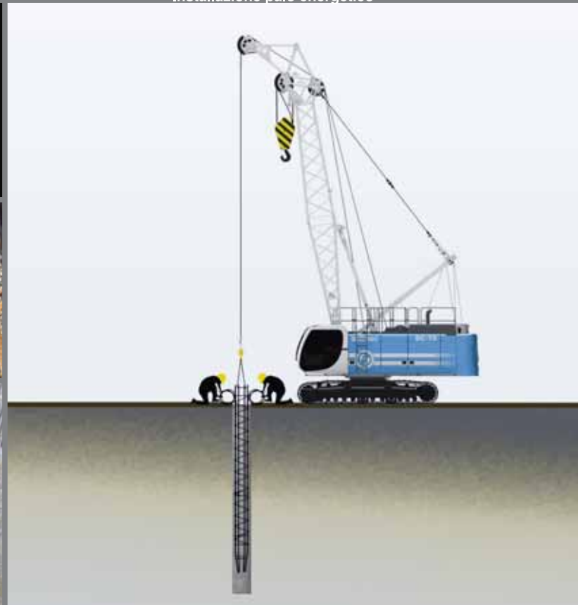
Installazione palo energetico
