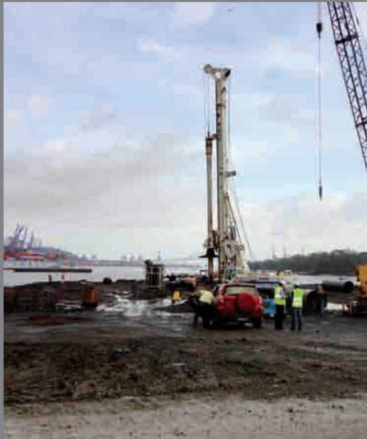
Para la construcción del nuevo muelle cerca de la entrada del lago Gatún, se han excavado pilotes encamisados de **1.500 mm de diámetro** para
