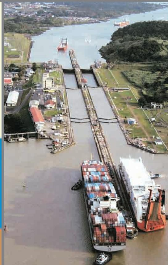
su construcción original. El proyecto prevé un nuevo carril de tráfico a lo largo del Canal mediante la construcción de un nuevo juego de esclusas que duplicará la capacidad del canal de navegación. El costo total de la obra es de 5,25 mil millones de dólares estadounidenses y consta de cuatro proyectos principales: la construcción de las nuevas esclusas, el nuevo canal de acceso al Pacífico, el dragado del canal de navegación y el aumento del nivel operativo máximo del lago Gatún.
