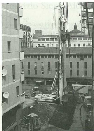
A sinistra: attrezzature Soilmec per l'esecuzione di paratie di pali CSP
