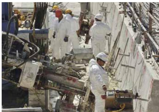
è stato necessario eseguire una nuova campagna di indagini, sia sul perimetro (*una perforazione ogni circa 30 m*), sia nell'area interna delle due discariche, con carotaggi, video ispezioni e prove di permeabilità delle zone interessate dall'eseguendo trattamento. Inoltre si è dato seguito ad una serie di campi prova per mettere a punto i dettagli tecnologici ed operativi e testare il raggiungimento degli obiettivi progettuali.
