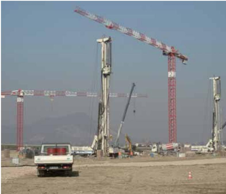
Un cantiere per la realizzazione di pali Discrepile consta di una **attrezzatura di perforazione**, di una **pompa idraulica cingolata** di ridotte dimensioni, di un **escavatore a braccio rovescio** per la movimentazione dell'eventuale minimo materiale di risulta e, se necessario, di una **gru di servizio** per l'infissione dell'armatura.
