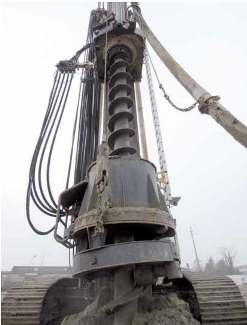
L'utensile di scavo è costituito da un'elica continua costituita da una batteria di elementi di varia lunghezza (da 1,5 a 6 metri), dotati di un'anima cava centrale attraverso la quale viene pompato il calcestruzzo.
